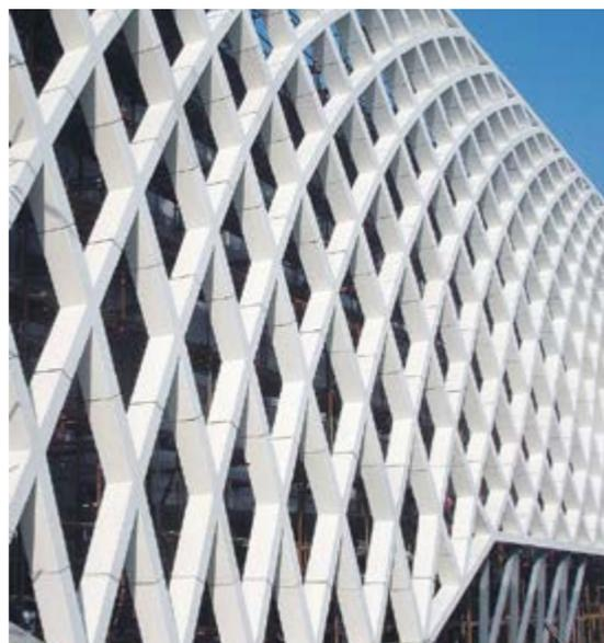
béton) et contribue à la réduction des coûts de transport, de manipulation et d'installation. Enfin, c'est un véritable produit durable qui ne peut ni pourrir ni se corroder du fait de sa faible perméabilité, de son excellente protection contre les intempéries et de sa résistance au gel ou dégel. Au final, un produit étonnant qui repousse les limites de l'imagination.
